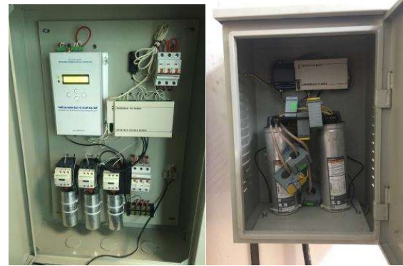
Hình 7: Thiết bị giám sát tủ bù hạ thế a) Trong PTN b) Thực tế
